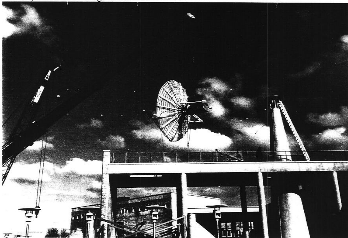
Figur 2. Den lange kran sætter antennen op på det nye tårn.
